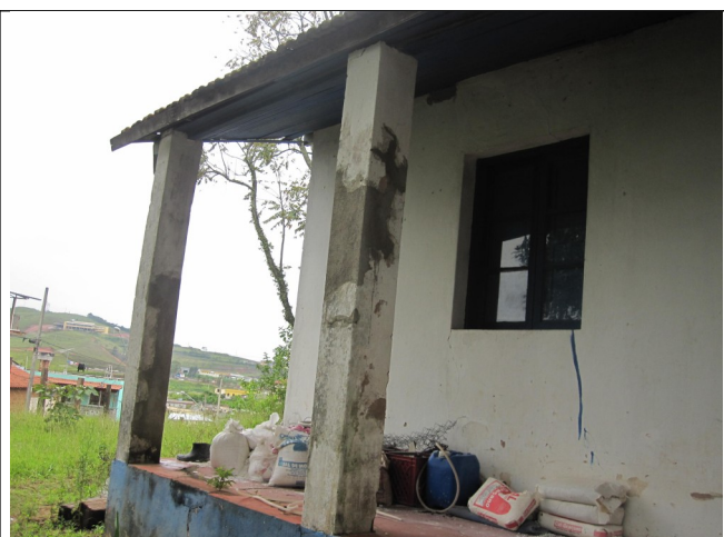
Figura 06 – Intervenções recentes no imóvel.
