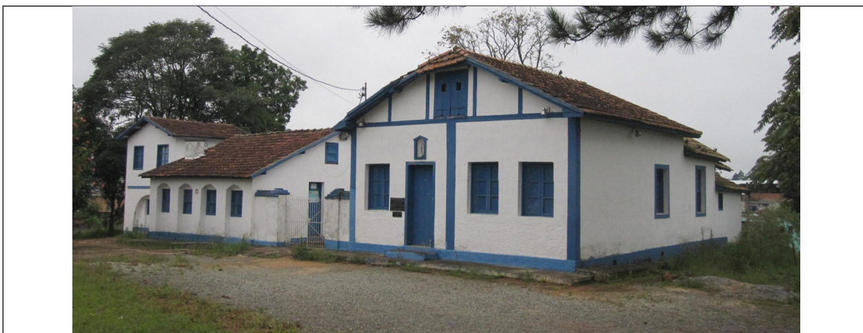
Figura 04 – Fachada frontal da edificação do Museu George Bernanos.
