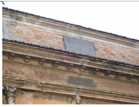
Figura 19 – Alvenaria de tijolos maciços sem reboco.
