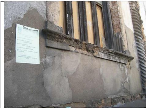
Figura 18 – Substituição do reboco por argamassa de cimento
