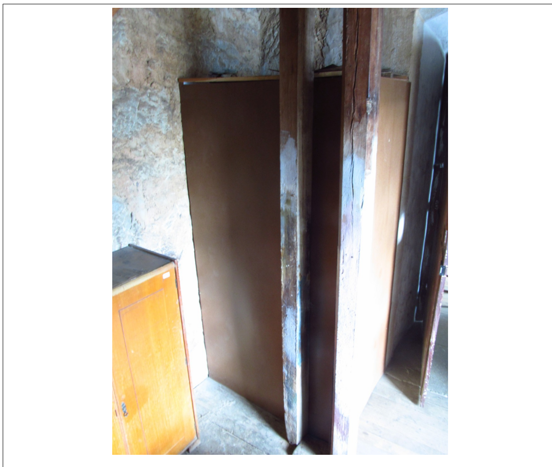
Figura 11 – Aspecto geral da caixa que resguarda o órgão.
