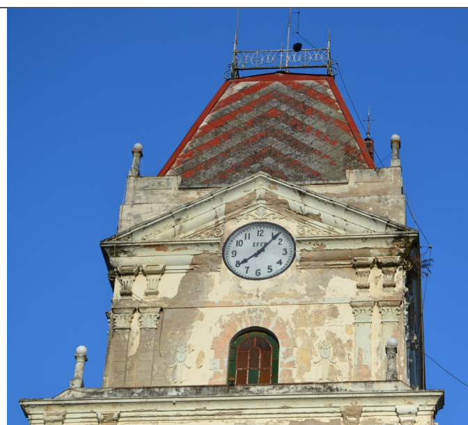
Figura 02 – Cobertura da torre e relógio.
