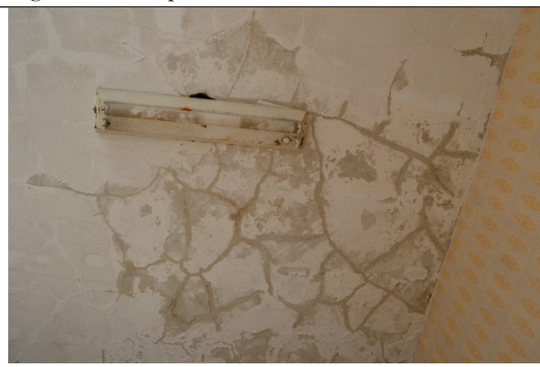
Figura 33 – Infiltrações.
