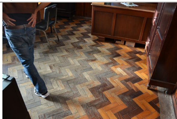
Figura 30 – Piso desgastado.
