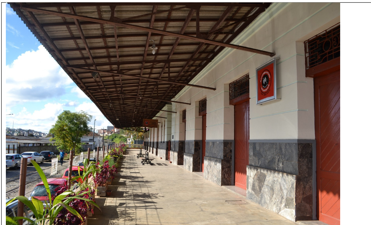
Figura 03 – Plataforma recuperada na lateral esquerda da estação.
