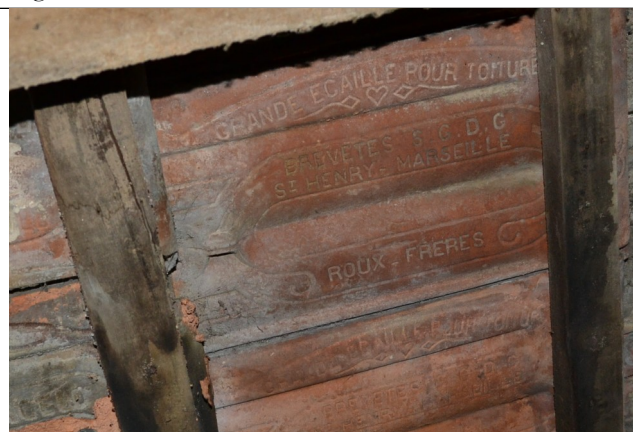
Figura 39 – Telhas francesas originais.
