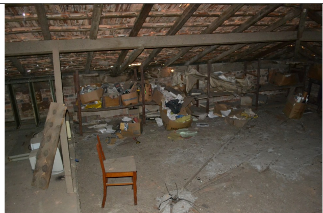
Figura 35 – Material armazenado no entreferro.
