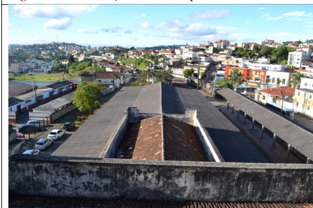
Figura 36 – Vista geral da cobertura.
