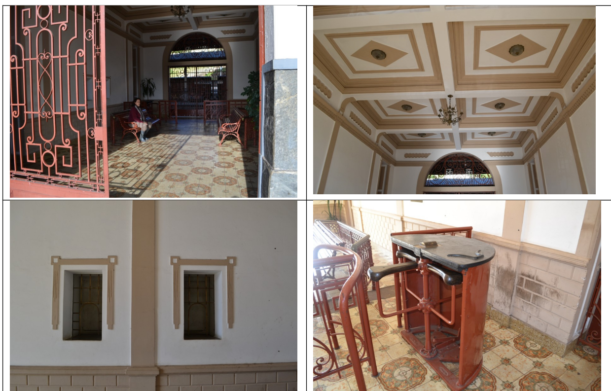
Figuras 18 a 21 – Elementos originais ainda preservados no saguão principal da estação: Portões, forros, gradis, luminárias, bilheterias, roleta.
