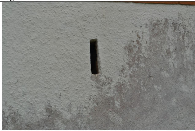
Figuras 11 e 12 – Imagens do vão (seteira) existente no porão da edificação.
