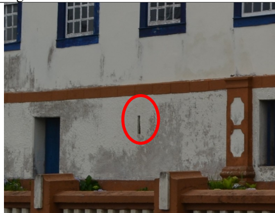
Figuras 11 e 12 – Imagens do vão (seteira) existente no porão da edificação.
