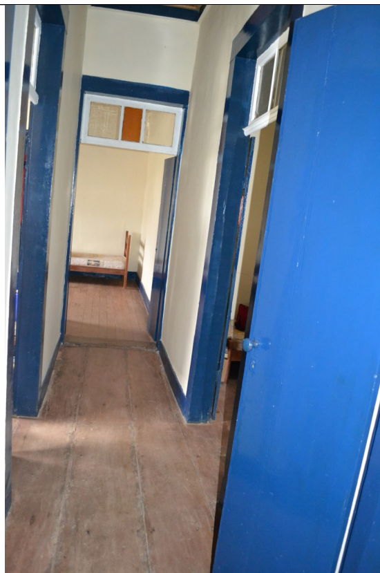
Figura 16 – Portas e piso tabuado originais.
