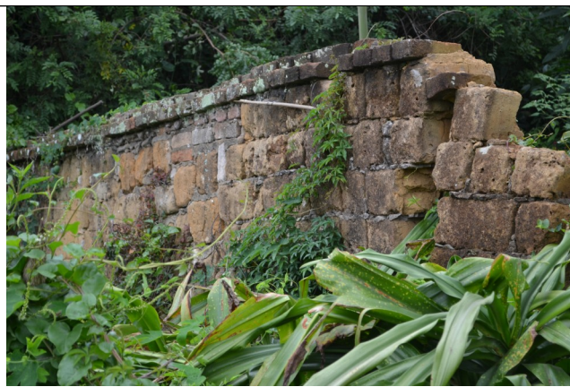
Figura 10 – Muro de adobe.
