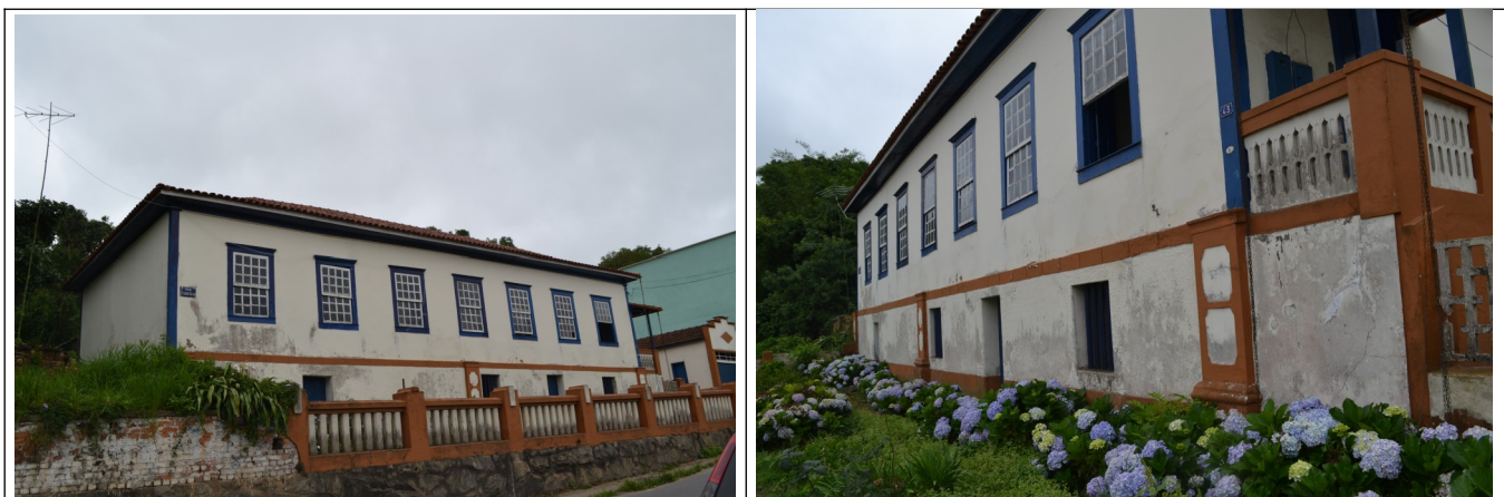
Figuras 05 e 06 – Imagens externas do imóvel da rua Cesário Alvim nº 43.
