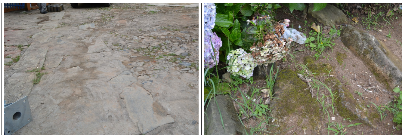
Figuras 07 e 08 – Piso em lajes de pedra.
