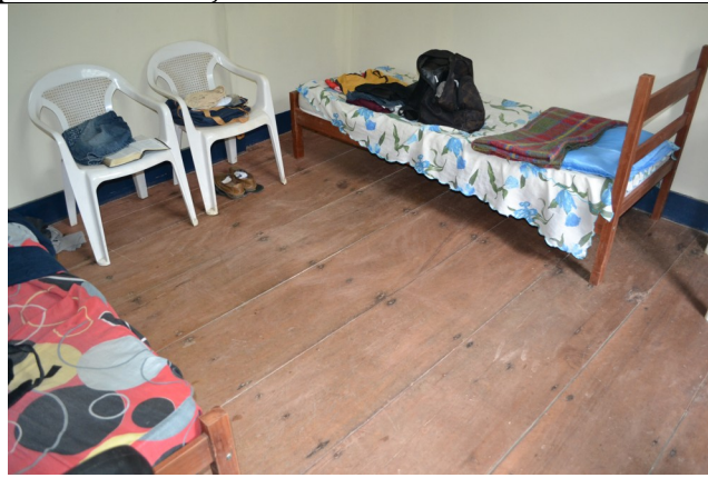
Figura 14 – Piso tabuado original.
