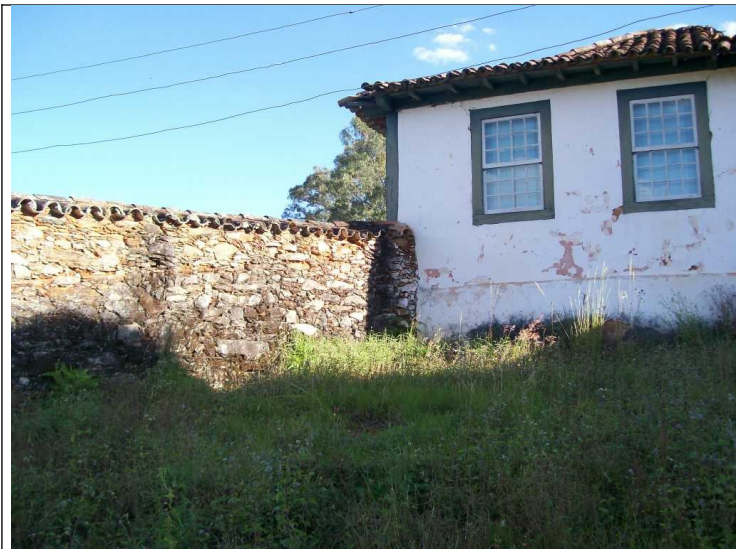
Figura 06 – Fazenda e muro de pedras (maio 2010).
