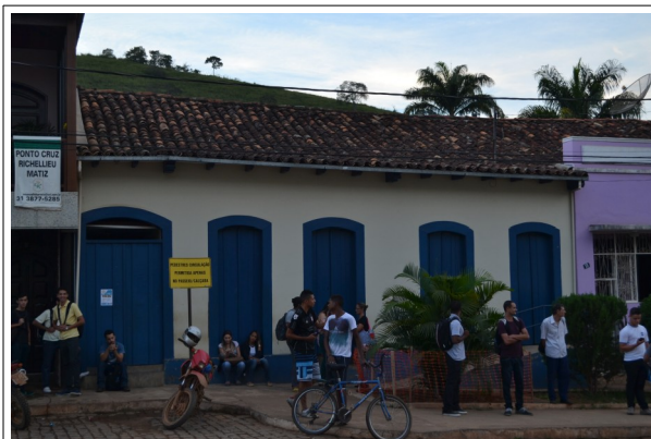
Figura 13 - Imóvel inventariado situado na rua Capitão Manuel Carneiro.
