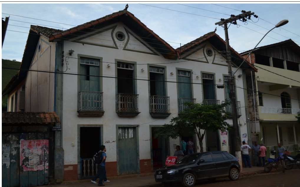
Figura 10 – Imóvel da rua Capitão Manuel Carneiro nº 130 / 140 em maio de 2016.
