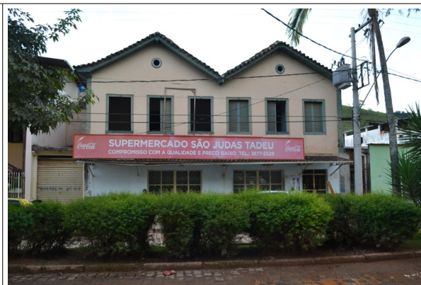
Figura 14 - Imóvel inventariado situado na rua Capitão Manuel Carneiro.
