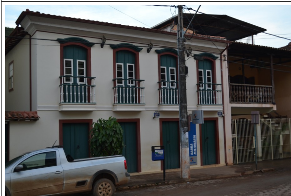
Figura 15 - Imóvel inventariado situado na rua Capitão Manuel Carneiro.
