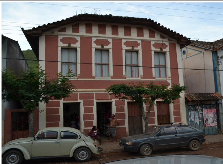
Figura 11 – Imóvel da rua Capitão Manuel Carneiro nº 154 em maio de 2016.
