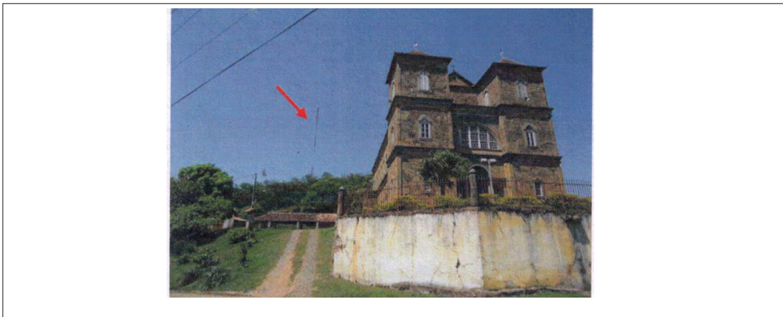
Figura 3- Igreja Matriz de São José das Três Ilhas, município de Belmiro Braga. Assinalada a torre instalada no entorno do templo. Fonte: Relatório de Vistoria, IEPHA, 2015.
