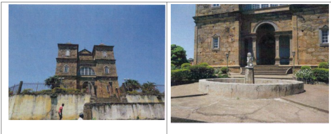
Figuras 4 e 5- Imagens externas da fachada da Igreja Matriz de São José das Três Ilhas. Fonte: Relatório de Vistoria, IEPHA, 2015.
