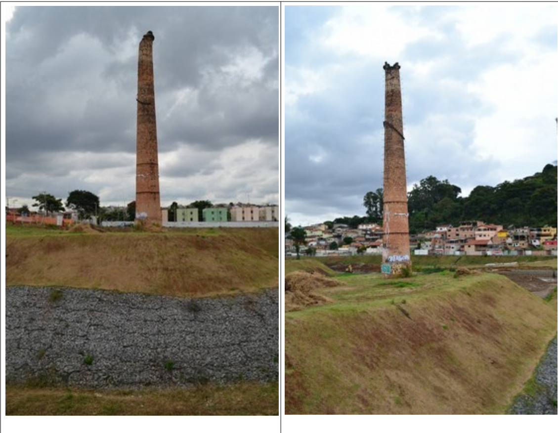
Figuras 10 e 11- Implantação da Chaminé da Olaria na parte mais elevada do terreno, com utilização de de gabiões para sustentar o talude. Foto da visita ao local.
