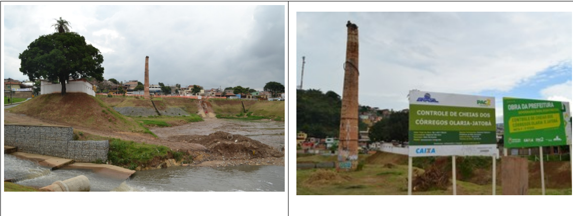
Figuras 6, 7, 8 e 9- Realização de obras no entorno da Chaminé da Olaria. Fotos da visita ao local.
