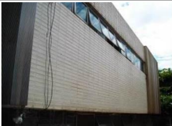
Figura 10 - Fachada lateral direita original.
