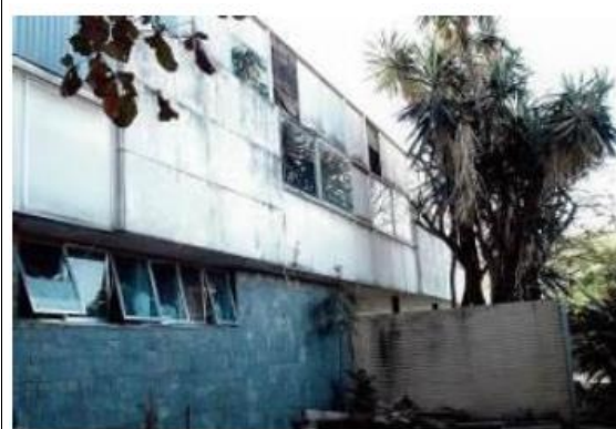
Figura 15 - Fachada dos fundos original.
