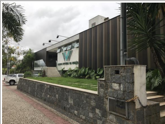
Figura 05 - Ausência do muro frontal.
