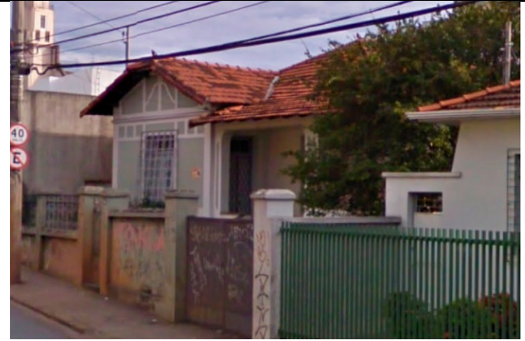
Figura 02 – Vista lateral da Fachada frontal da casa à Rua Padre Eustáquio, nº 544, Carlos Prates, com Igreja São Francisco das Chagas ao fundo. Fonte: Google Street View, julho de 2009.
