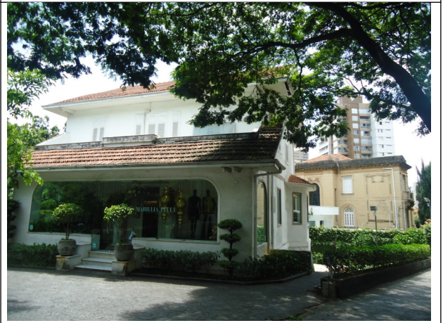
Figura 13 - Imóvel localizado na avenida Bias Fortes nº 161.
