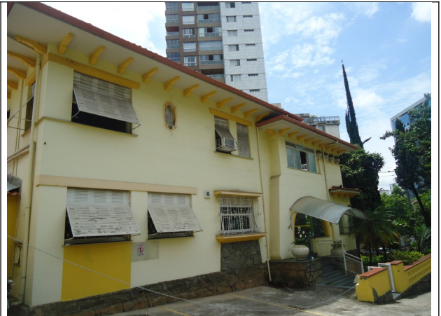
Figura 11 – Imóvel localizado na avenida Bias Fortes nº 247.
