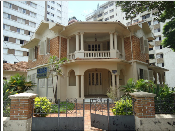
Figura 10 - Imóvel localizado na avenida Bias Fortes nº 309.
