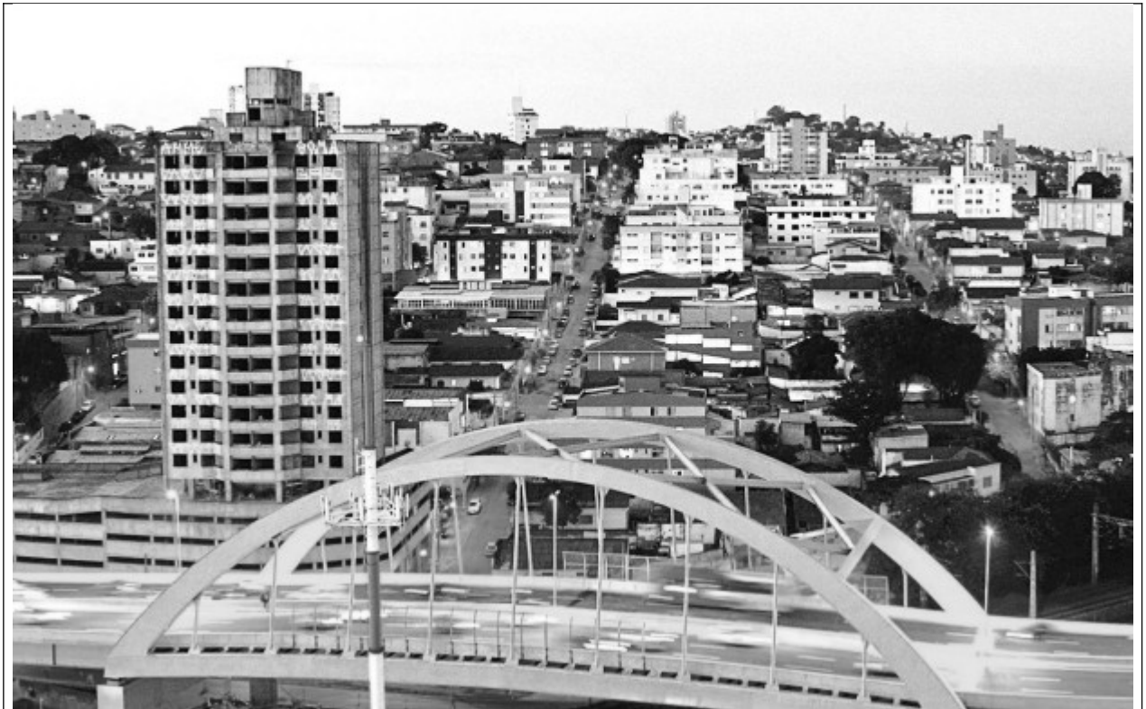
Figura 03 – Vista aérea do viaduto Itamar Franco. Disponível em: www.BeloHorizonteminhaterra.blogspot.com .
