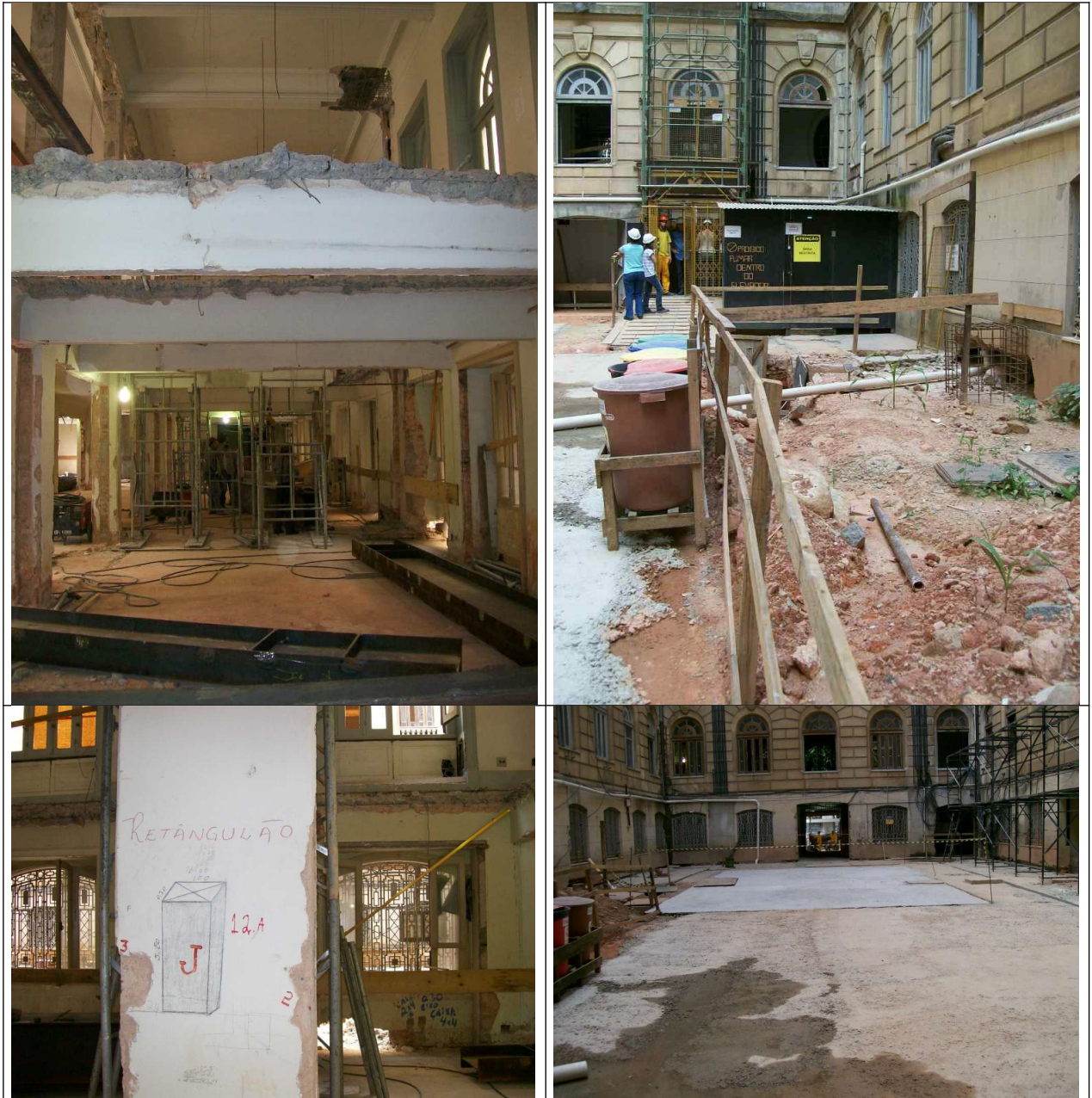
Figuras 04, 05, 06 e 07- Obras no antigo prédio da Secretaria de Segurança Pública. Fonte: Acervo da CPPC, vistoria realizada em 03-02-2011.
