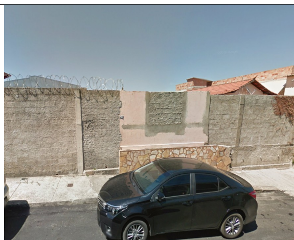
Figura 23 – Rua do Serro 295. Imagem atual.
