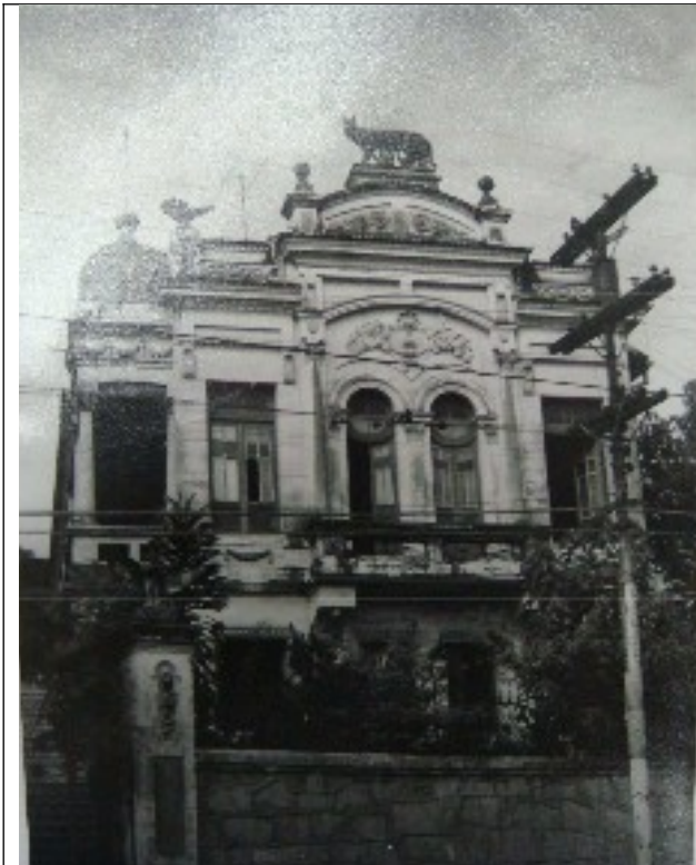
Figura 08 – Imagem antiga da edificação.
