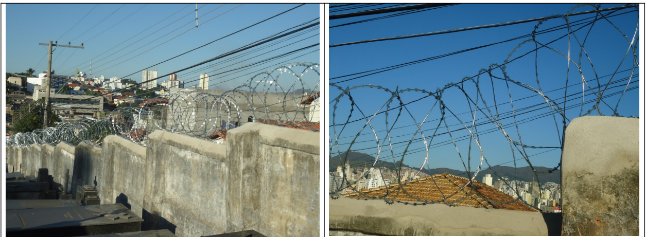
Figuras 13 e 14 – Concertina sobre o muro circundante, sem deixar espaços livres.
