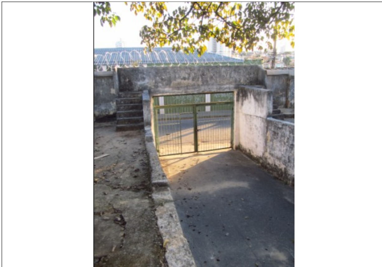
Figuras 10 e 11 – Acesso pela rua Jaguari sem a devida segurança.
