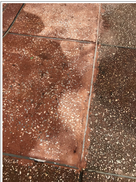
Figura 06 - Trecho onde o piso foi substituído., junto ao antigo revestimento.
