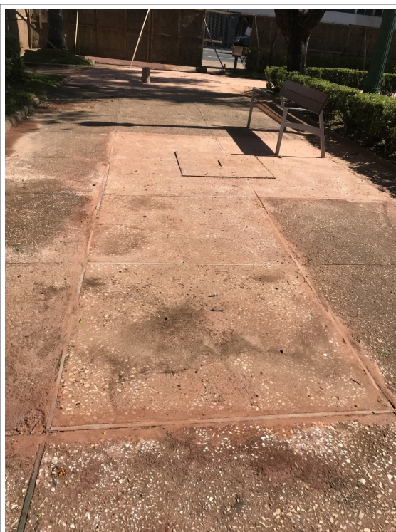
Figura 07 - Trecho onde o piso foi substituído., junto ao antigo revestimento.
