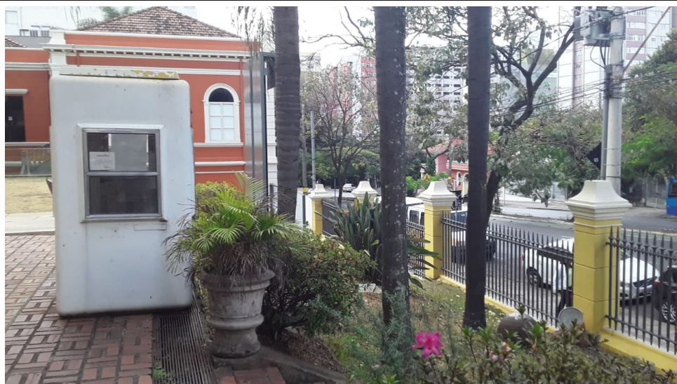
Figura 9 – Guarita na escada de acesso. Nota-se que não há vigilante no local. Fonte: CPPC.
