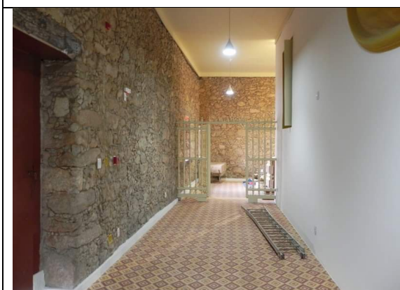
Figura 03 – Corredor da sacristia da Matriz de São Gonçalo do Amarante após o restauro.
