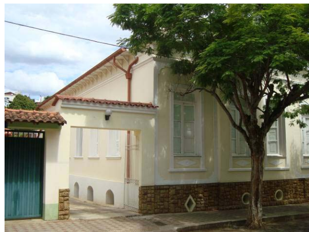
Vista da fachada frontal da edificação e de parte do afastamento lateral direito.
