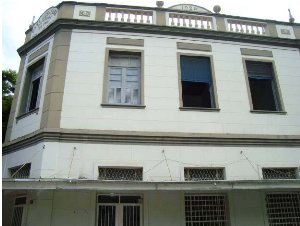
Vista da edificação a partir da Avenida Getúlio Vargas. IMAGEM: Rafael Vilela, out/2011.
