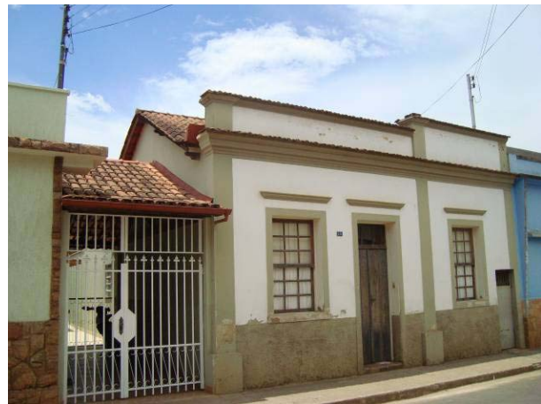
Vista da fachada frontal e de parte da lateral direita da edificação.
