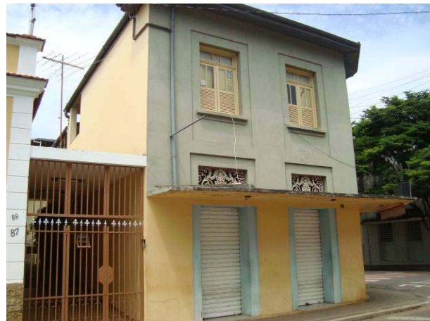
Vista a partir da Avenida Getúlio Vargas – fachada frontal.
