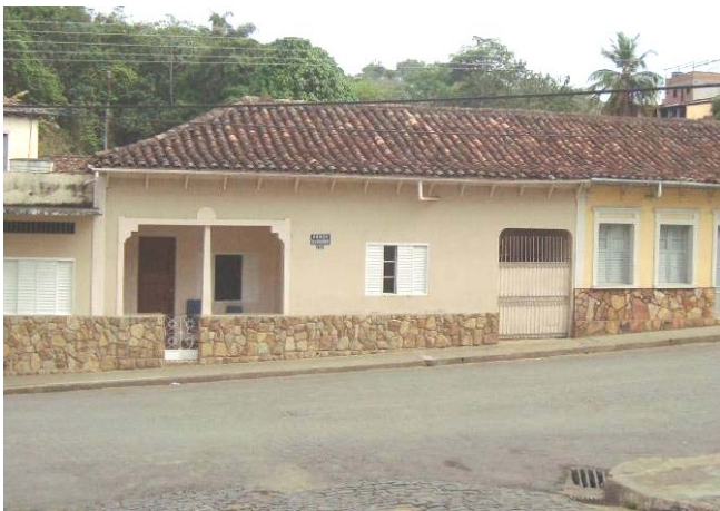
Vista da fachada frontal da edificação.
