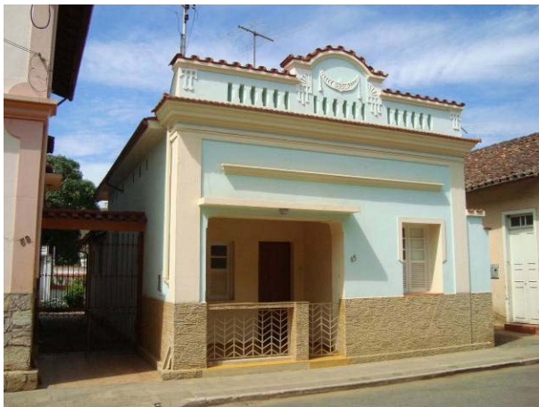
Vista da fachada frontal e do afastamento lateral direito da edificação.
