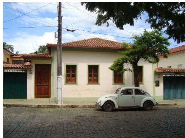
Vista da fachada frontal da edificação.
