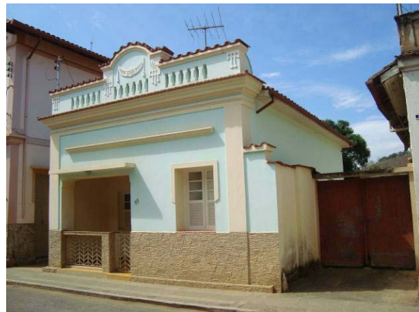
Vista da fachada frontal e de parte da lateral esquerda da edificação.
