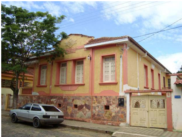
Perspectiva da edificação à Av. Avelino Sarmiento nº 0043.
