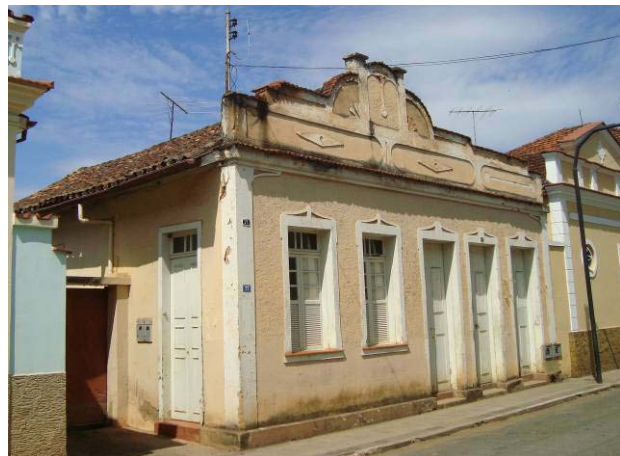
Vista da fachada frontal e de parte da lateral direita da edificação.
