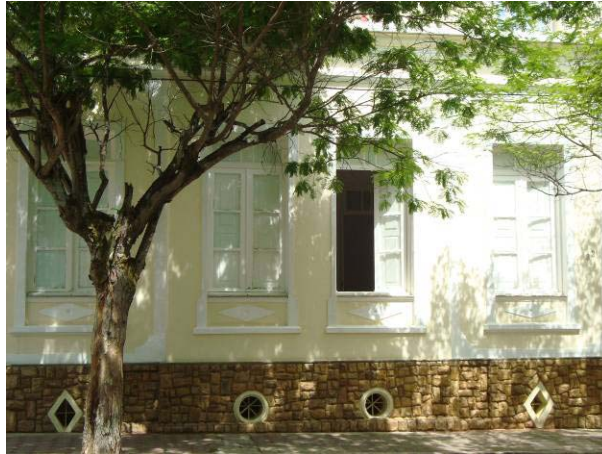
Detalhe das esquadrias e do embasamento da fachada frontal.
