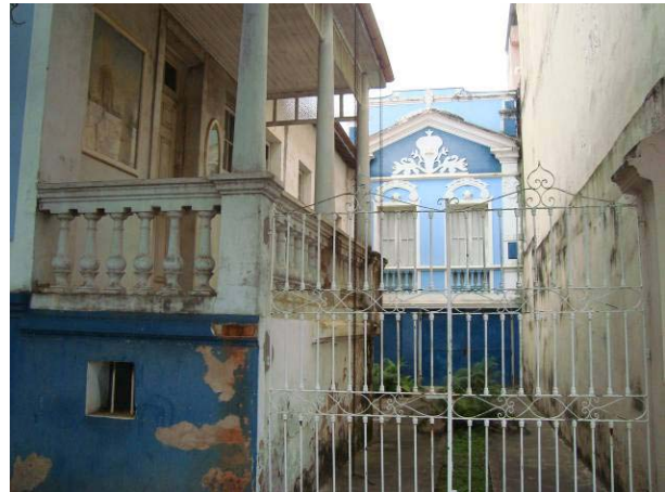
Vista do afastamento lateral esquerdo da edificação; e ao fundo, o anexo mais recente da mesma. IMAGEM: Rafael Vilela, out/2011.
