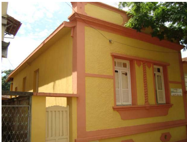
Vista da fachada frontal e de parte da lateral direita da edificação.
