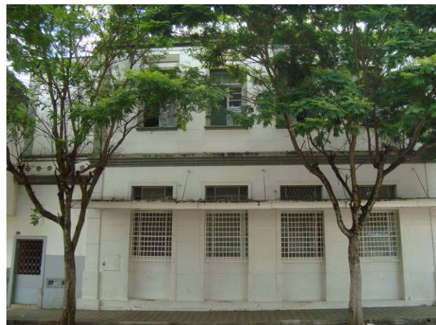
Vista da edificação a partir da Avenida Avelino Sarmiento.
