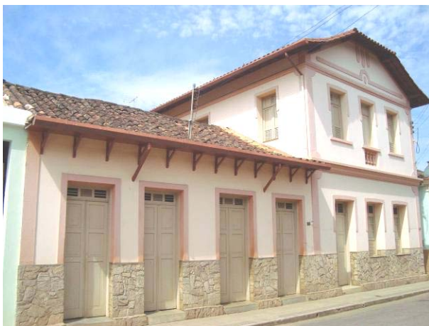
Vista da fachada frontal da edificação.
