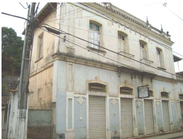
Vista da fachada frontal e de parte da fachada lateral direita da edificação.
