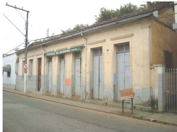
Vista da fachada frontal do imóvel à Av. Getúlio Vargas nº 0064/0070/0074.
