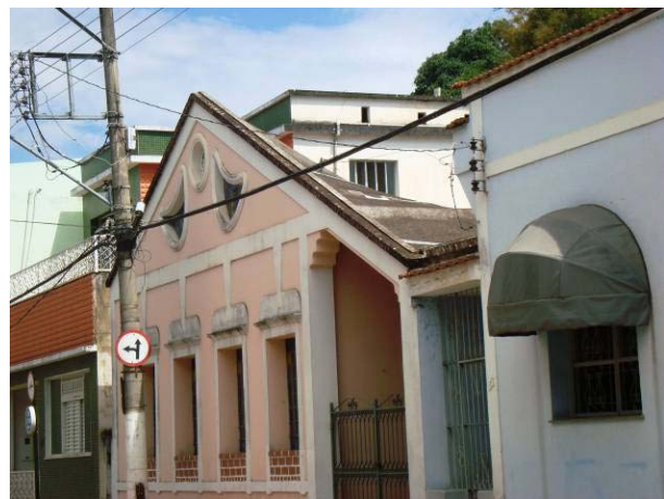
Perspectiva da edificação e sua cobertura (laje). IMAGEM: Rafael Vilela, out/2011.
