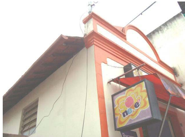
Detalhe dos coroamentos frontal e lateral direito: platibanda e beiral simples, respectivamente.
