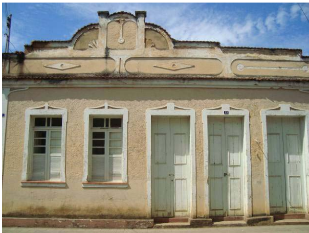
Vista da fachada frontal da edificação.
