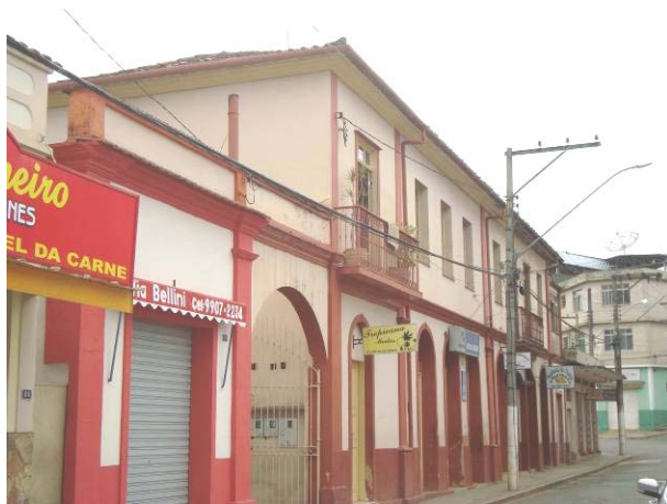
Vista da fachada frontal e de parte da fachada lateral direita da edificação.
