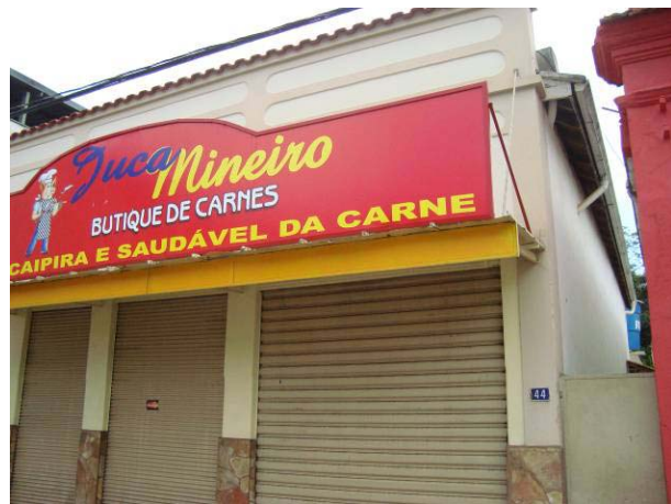
Vista das fachadas frontal e lateral esquerda da edificação. IMAGEM: Rafael Vilela, out/2011.
