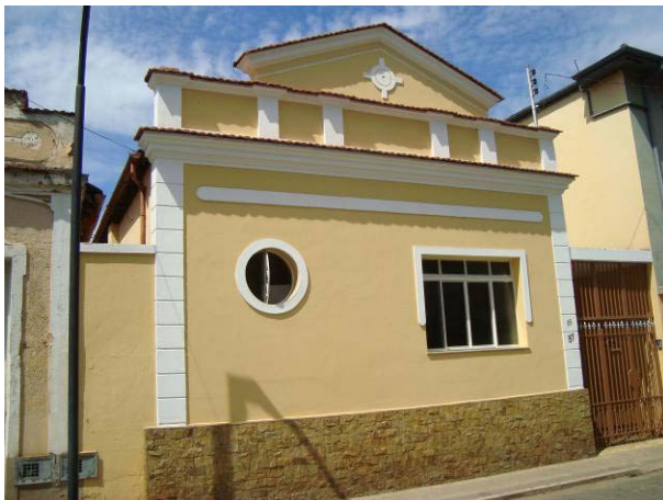
Vista da fachada frontal da edificação.
