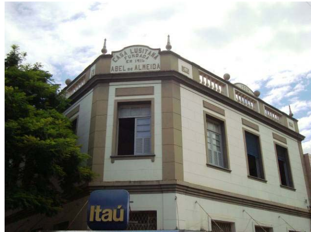
Vista do segundo pavimento da edificação. IMAGEM: Rafael Vilela, out/2011.
