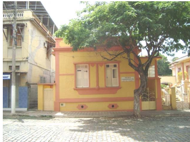
Vista da fachada frontal da edificação.
