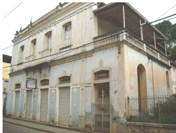
Vista da fachada frontal e de parte da fachada lateral esquerda da edificação.
