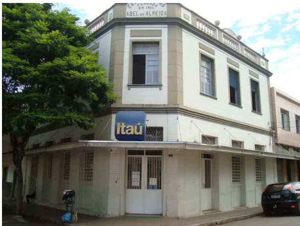
Perspectiva da edificação. IMAGEM: Rafael Vilela, out/2011.
