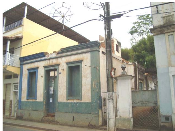
Vista das fachadas frontal e lateral esquerda da edificação.
