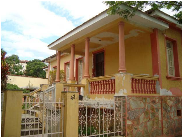
Vista da fachada frontal e de parte do afastamento lateral direito da edificação.
