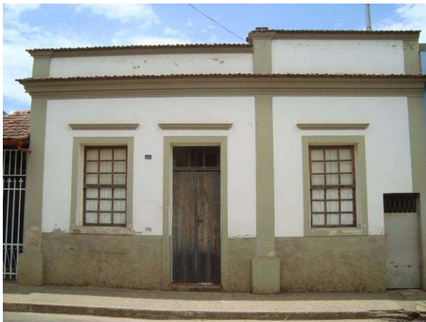
Vista da fachada frontal da edificação.
