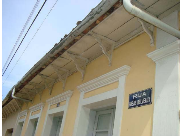
Detalhe dos enquadramentos dos vãos e também do coroamento frontal.
