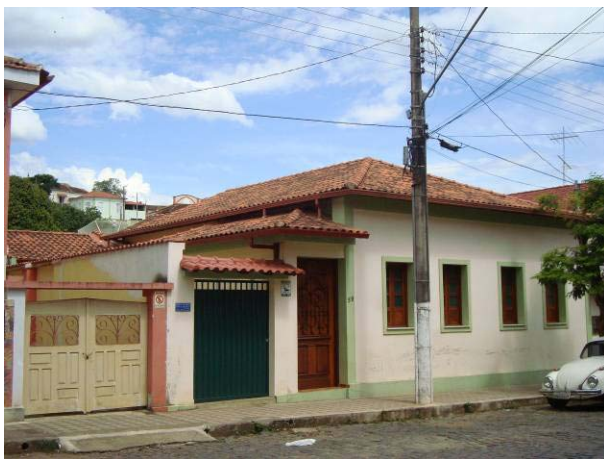
Vista da fachada frontal e de parte da lateral direita da edificação.
