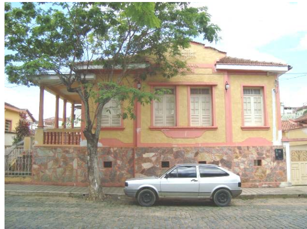
Vista da fachada frontal da edificação.
