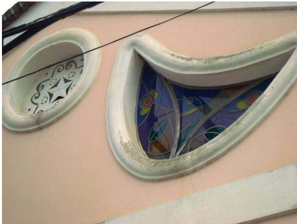
Detalhe de dois dos óculos da fachada frontal.
