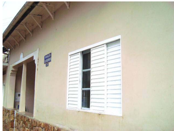
Detalhe da esquadria, do coroamento frontal e do enquadramento do vão da varanda frontal de acesso.
