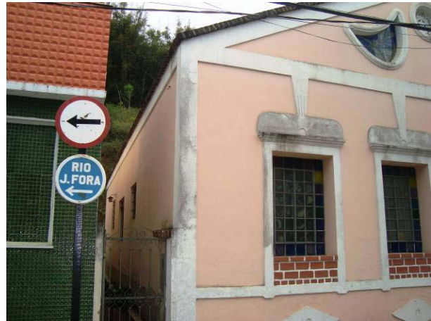
Vista da fachada lateral direita da edificação.
