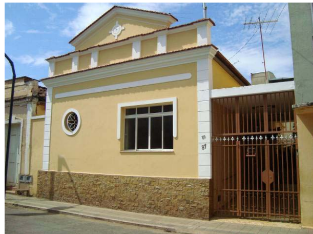
Vista da fachada frontal e de parte do afastamento lateral esquerdo da edificação.
