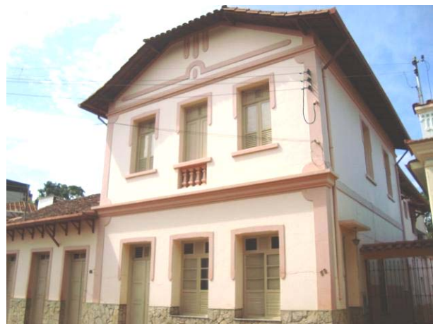
Vista da fachada frontal e do afastamento lateral esquerdo da edificação.
