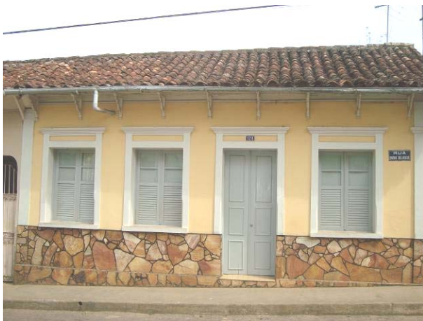
Vista da fachada frontal da edificação.
