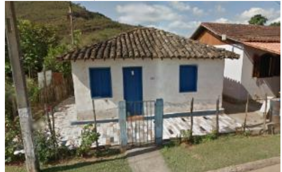
FIGURA 54 Edificação de D. Efigênia Fernandes, à Rua São Bento, nº 322 – Bento Rodrigues, Mariana. Época: década de 1980. Sistema construtivo: tijolinho. Casa original de pau a pique, provavelmente dos Séc. XVIII a XIX. Fonte: Grupo WhatsApp Memórias das Casas Bento , década de 2000.
