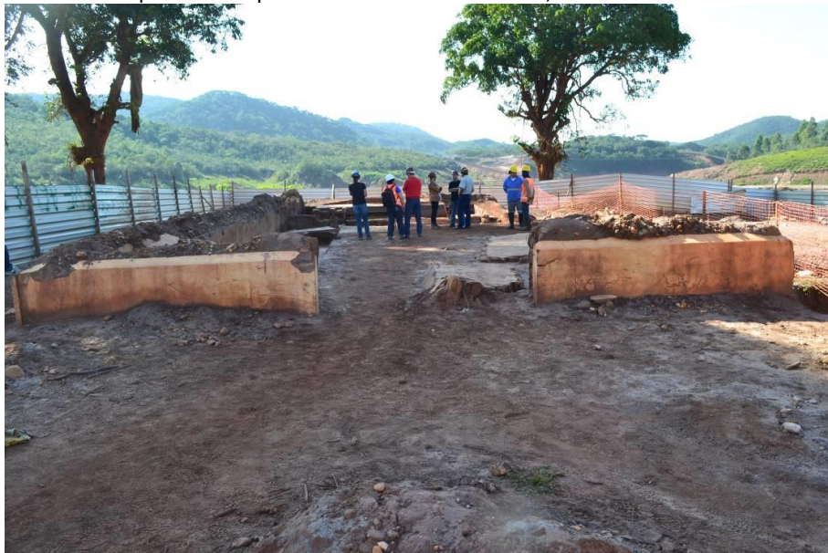
FIGURA 98 Capela de São Bento em maio de 2016 durante processo de escavação da lama sobre o piso de campas de madeira. Foto: MPMG, maio 2016
