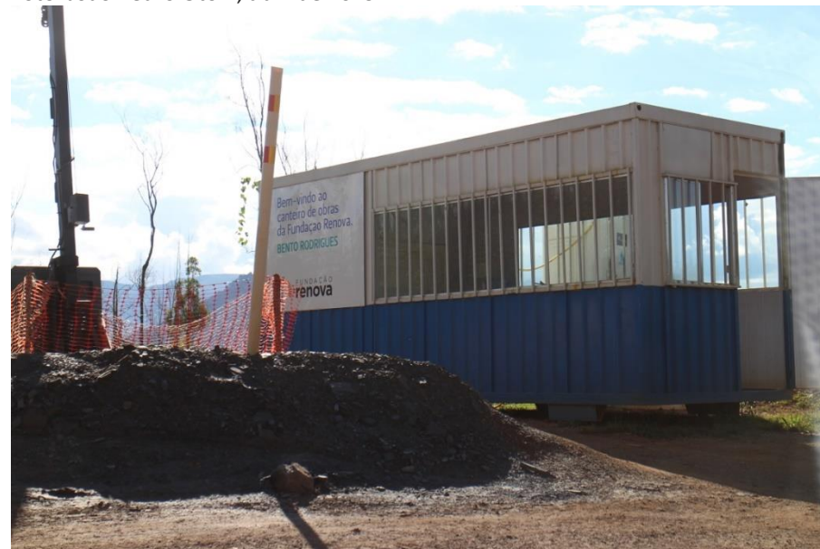
FIGURA 89 Canteiro de obras da Fundação Renova, construção da “Nova Bento”. Foto: João Pedro Otoni, abril de 2019
