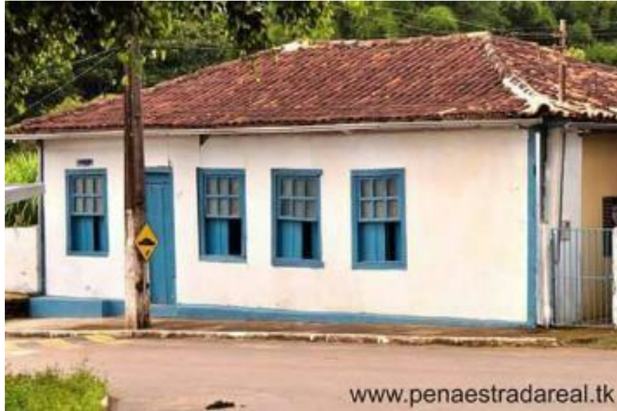
FIGURA 53 Edificação à Rua São Bento nº 107 – Bento Rodrigues, Mariana. Época: Século XVIII. Sistema construtivo: estrutura de madeira, vedação empau a pique. Fonte: Grupo WhatsApp Memórias das Casas Bento , década de 2000.
