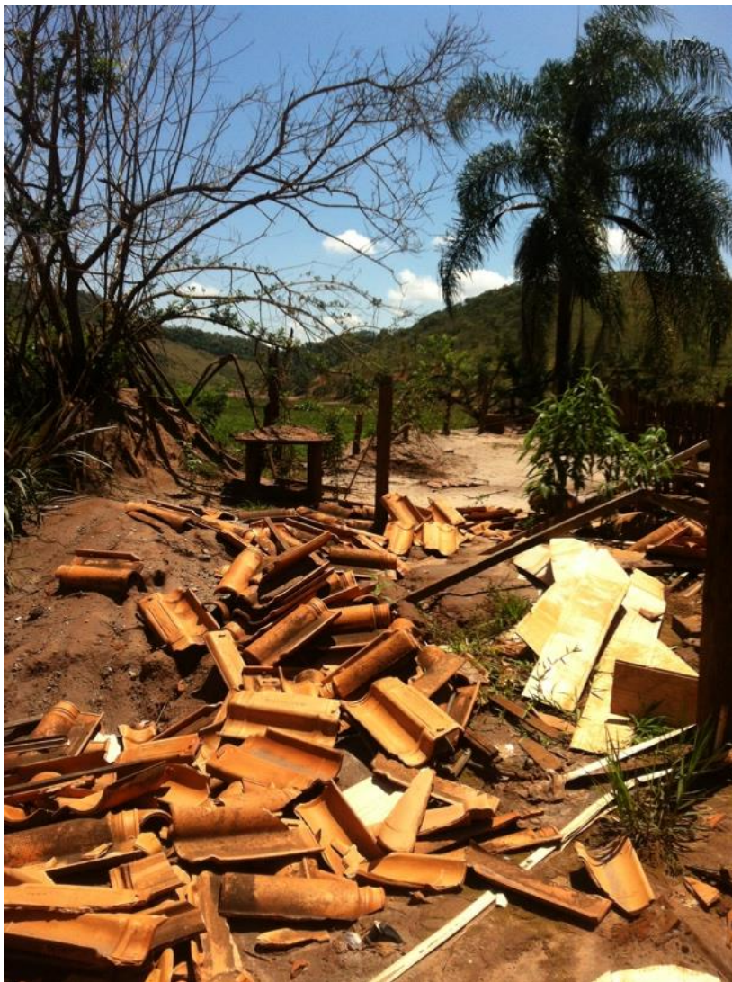
FIGURA 68 Paracatu de Baixo após o rompimento da barragem. Foto Teresa C. Guerra Andrade, outubro 2016.
