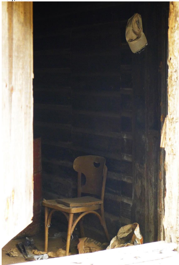
FIGURA 126 Sala de uma das casas saqueadas na parte alta de Bento. Foto: Samantha Nery, 2016.
