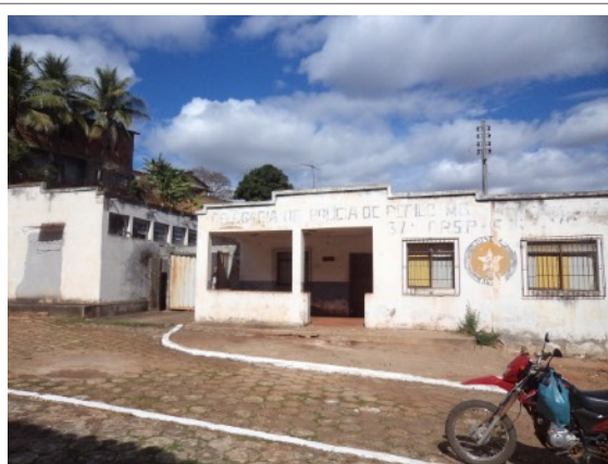
Figura 25 – Na fotografia acima, verifica-se à esquerda da imagem o cômodo no qual se encontrava o cofre. Nota-se que estava ao lado do prédio da Delegacia de Polícia.
