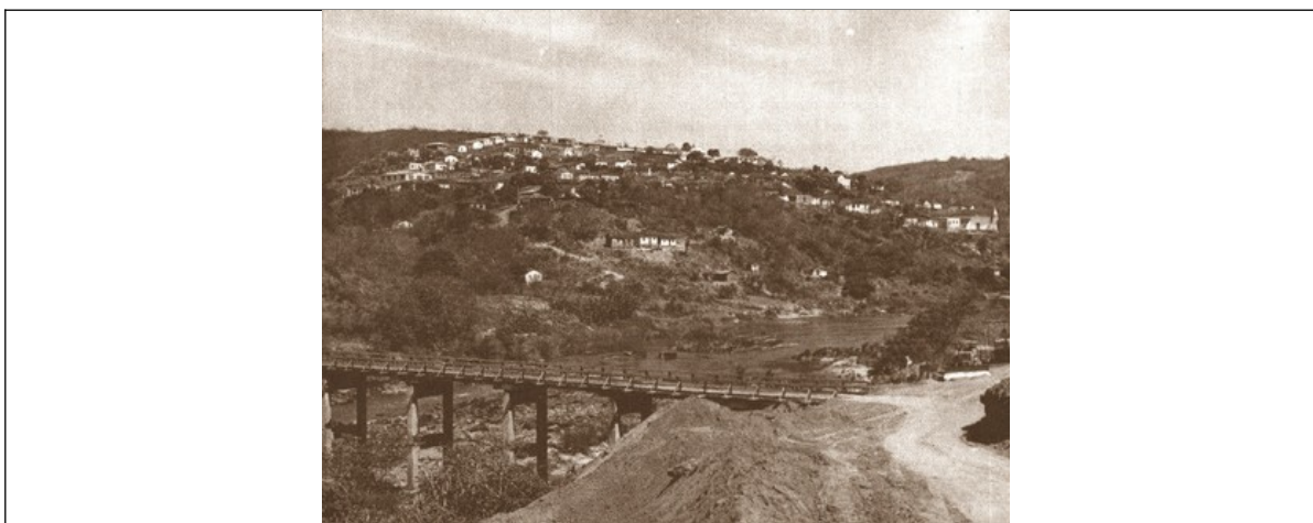
Figura 2– Vista geral de Berilo. Registro fotográfico datado de 1978. Em destaque na fotografia a ponte sobre o rio Araçuaí.
