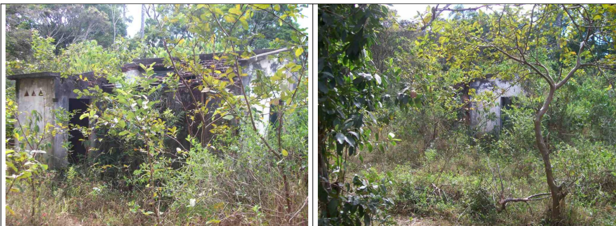
Figuras 05 a 06 – Antiga construção que abrigava o gerador de energia, antes da chegada da rede elétrica. Também apresenta-se todo tomado pela vegetação e com a estrutura danificada.
