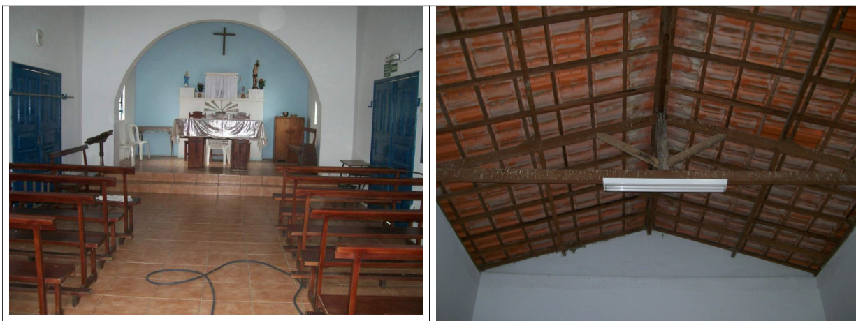
Figuras 07 e 08 – Imagens internas da edificação.
