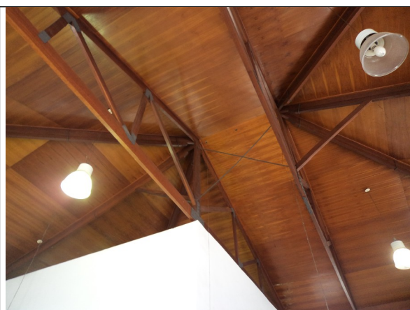
Figura 22 – No registro fotográfico verifica-se as boas condições do telhado. Também é possível observar que as demais lâmpadas, assim como foi mostrado na figura 18, encontram-se distanciadas do acervo. Fonte: CPPC.
