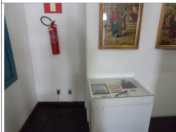
Figuras 23 e 24 – Presença do extintor de incêndio na exposição do Padre Osório. Na figura 24 verifica-se que não há etiqueta de inspeção periódica. Fonte: CPPC.
