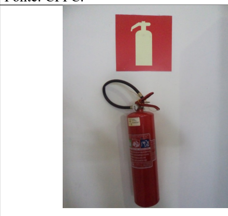
Figuras 23 e 24 – Presença do extintor de incêndio na exposição do Padre Osório. Na figura 24 verifica-se que não há etiqueta de inspeção periódica. Fonte: CPPC.
