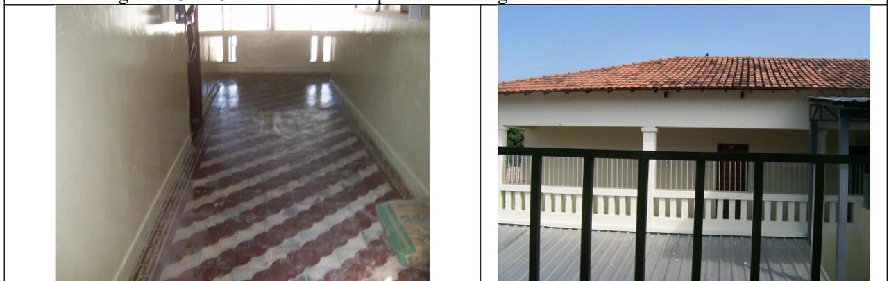
Figuras 17 e 18 – Detalhes do piso em ladrilho hidráulico e da cobertura. Fonte: CPPC
