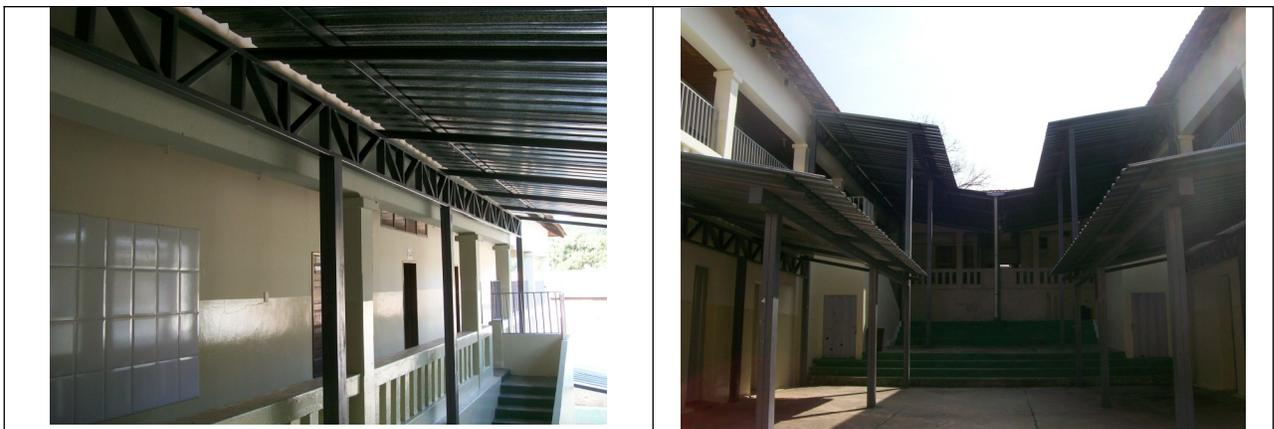
Figuras 13 e 14 – Detalhes da cobertura em estrutura metálica já existente. Fonte: CPPC.
