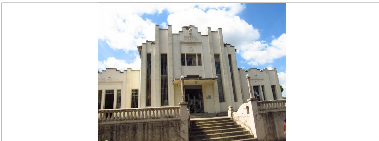
Figura 05 – Cine-Teatro Glória, em 2014, com presença de fissuras generalizadas nas alvenarias externas. Foto: Neise Duarte, dez/2014.
