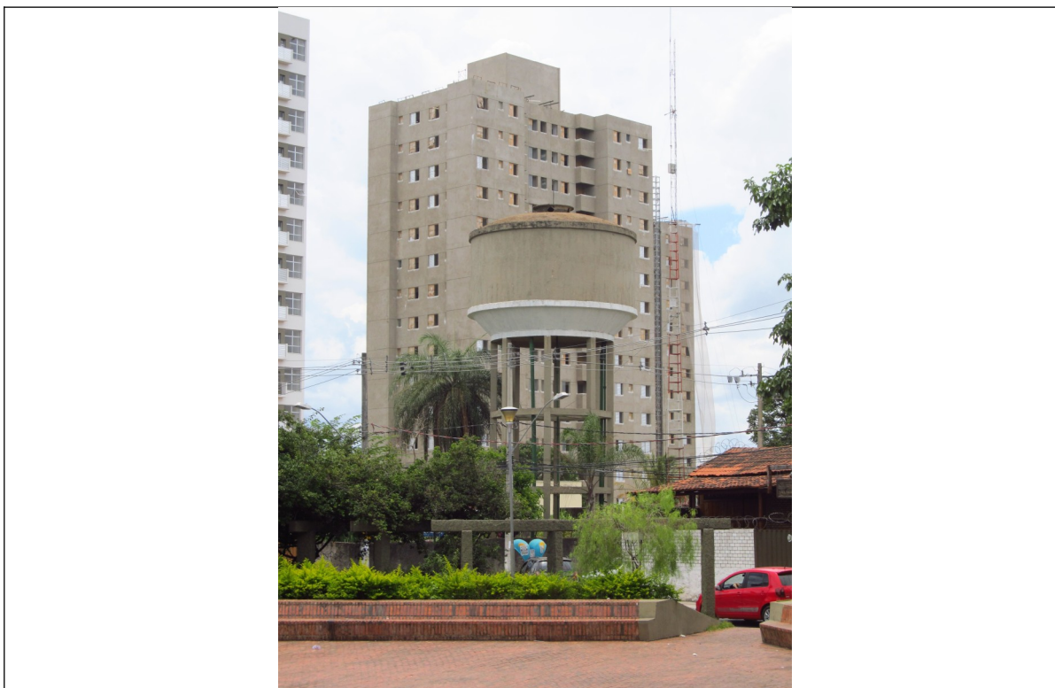
Figura 4 – Registro fotográfico aproximado da Caixa d'água. Fonte: CPPC.
