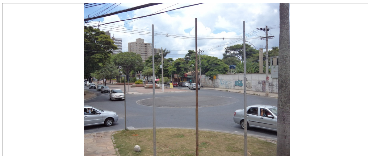
Figura 3 – Panorâmica da área na qual está inserida a caixa d'água de Betim, entorno imediato. Fonte: CPPC.
