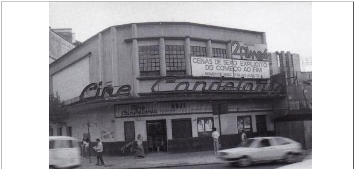
Figura 02 - Fotografia antiga do Cine Candelária. Nota-se o barrado em granito preto absoluto na fachada do prédio (que o projeto de intervenção proposto não contempla).
