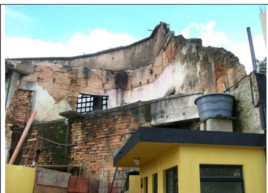
Figura 10 – Alvenarias remanescentes da fachada .
