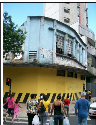
Figura 03 – Vista das fachadas da Praça Raul Soares e Bias Fortes.
