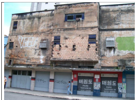
Figura 11 – Fachada dos fundos, voltada para a rua dos Goitacazes.
