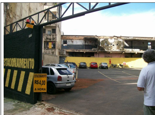
Figura 08 – Viga metálica e portão instalados junto à fachada da av. Bias Fortes.
