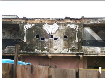
Figura 17 – Alvenaria remanescente, junto à fachada dos fundos, onde ficava a sala de projeção. Veja ornamentação de gesso ainda existente.
