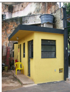
Figura 09 – Guarita e instalações sanitárias construídas.
