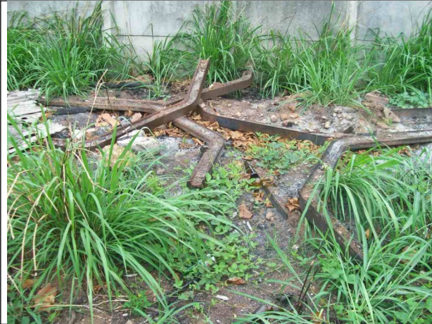
Figura 12 – Estruturas em ferro da antiga plataforma de embarque.
