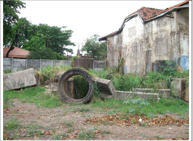
Figura 13 – Estruturas em concreto encontradas.
