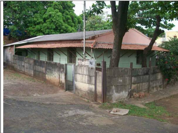
Figura 26 – Edificação ao lado da estação.
