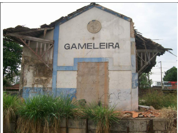
Figura 16 – Fachada lateral esquerda.
