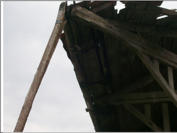
Figura 24 – Detalhe do telhado – calha deslocada e telhas faltando.
