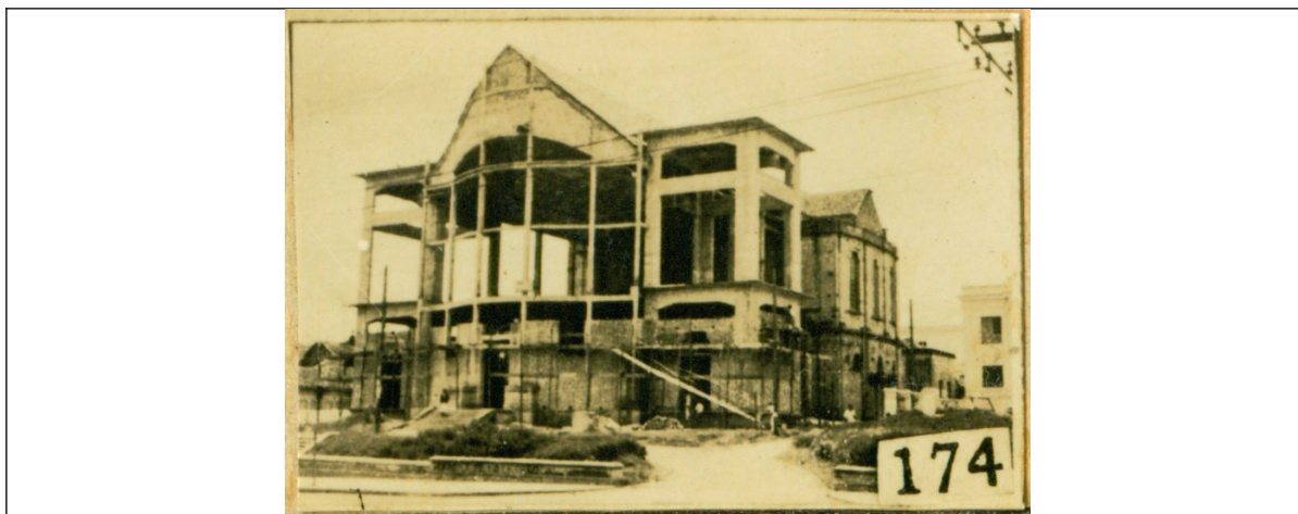
Figura 12 – Igreja de São Sebastião, data de 1947 em construção. Fonte: MHAB.
