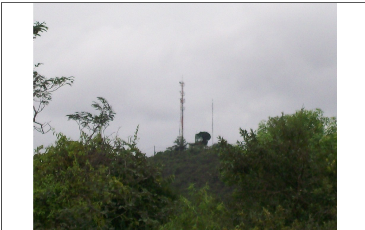
Figura 02 – Torres existentes no Posto 9 – Parque das Mangabeiras.
