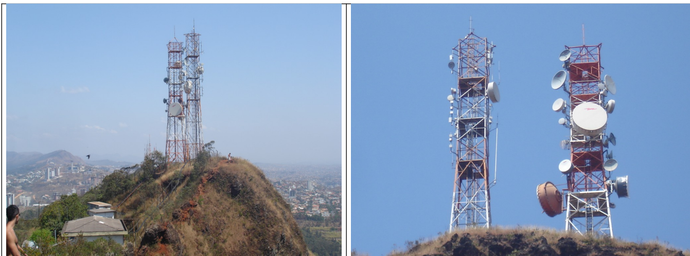
Figuras 04 e 05 – Estação “Centelha II” com equipamentos da PMMG e Telemig Celular (Vivo).
