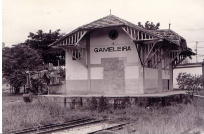
Figura 5 – A estação em março de 1997.
