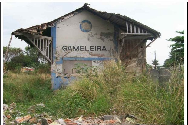
Figura 21 – Fachada lateral direita.
