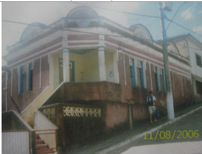
Figura 06 – Imóvel inventariado no ano de 2007, uso residencial.
