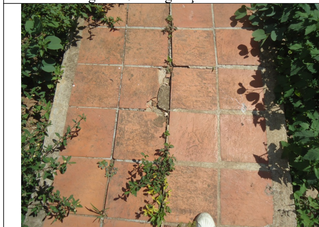
Figura 22 – Pavimentação danificada.
