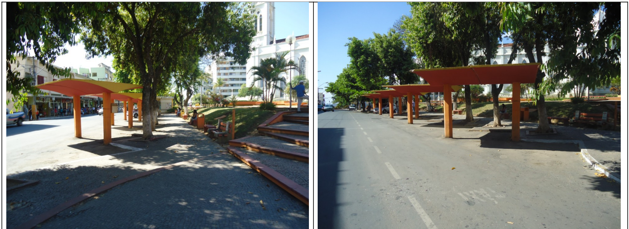
Figuras 19 e 20 – Vista das coberturas de concreto armado e da delimitação de vagas na calçada.
