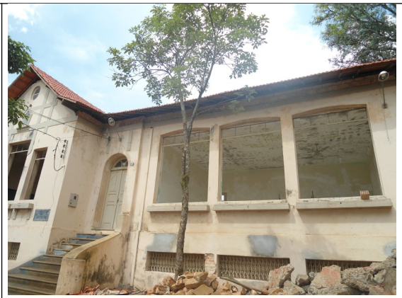
Figura 02 – Fachada após reforma.
