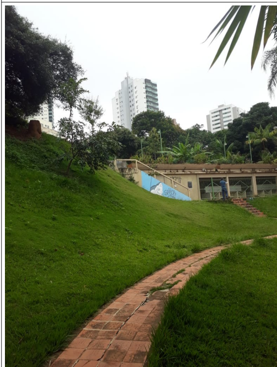
Figura 05 - Gramado em bom estado. Piso cerâmico com trinca e vegetação invasora.
