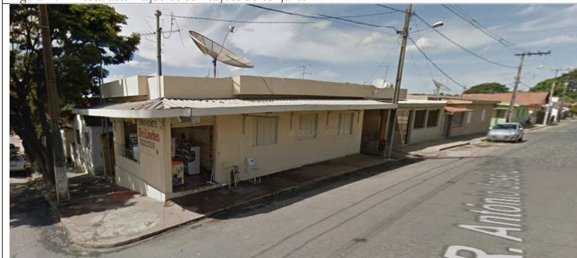
Figura 15 – Descaracterização de edificações do conjunto.
