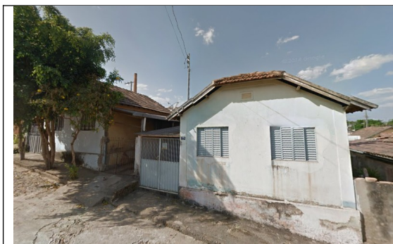
Figura 11 – Construção de coberturas e garagens nas edificações.
