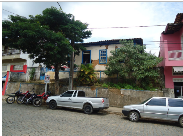
Figura 05 – Fachada frontal da edificação.
