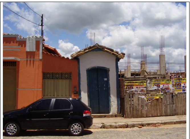
Figura 07 - Detalhe do Passo e, ao fundo, a estrutura da nova edificação (FONTE: Honório Nicholls Pereira, janeiro/2010).
