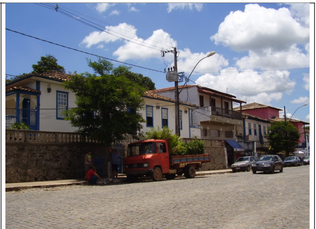
FIGURA 02 – Detalhe das edificações situadas em frente ao “Passo 1” e às casas que foram demolidas. Nesse lado da rua, as casas mais antigas apresentam, em geral, um pavimento e estão implantadas acima do nível da rua. O casario ficou com essa aparência fragmentada e confusa. (FONTE: Honório Nicholls Pereira, janeiro/2010).
