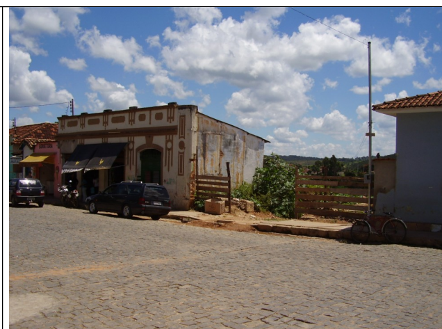
Figura 04 - Detalhe do lote vago ao lado do imóvel eclético, em abril de 2008 (FONTE: Honório Nicholls Pereira, abril/2008).
