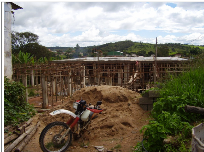
Figura 06 - Vista da construção no fundo do lote, em abril de 2009. Nesse momento, a nova laje atingia o nível da rua (FONTE: Honório Nicholls Pereira, abril/2009).
