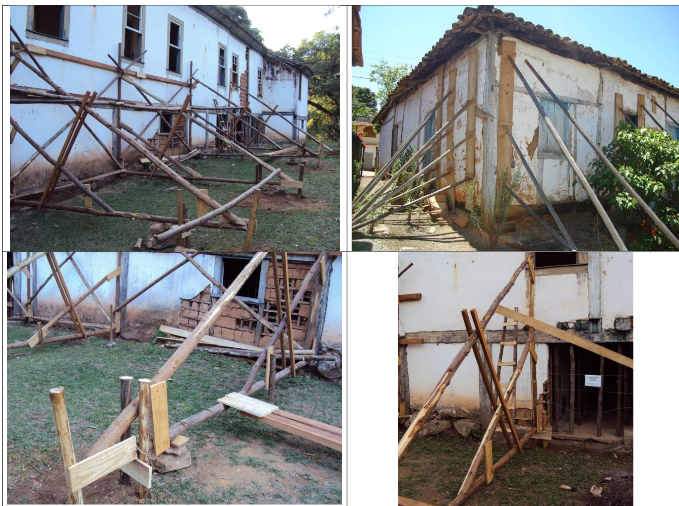
Figuras 04 a 07 – Escoramento de alvenarias.
