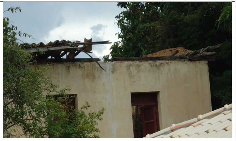
Figuras 12 e 13 – Cobertura arruinada nos fundos da edificação.
