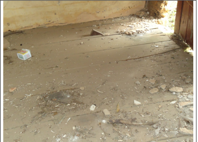
Figura 12– Piso em tabuado de madeira.
