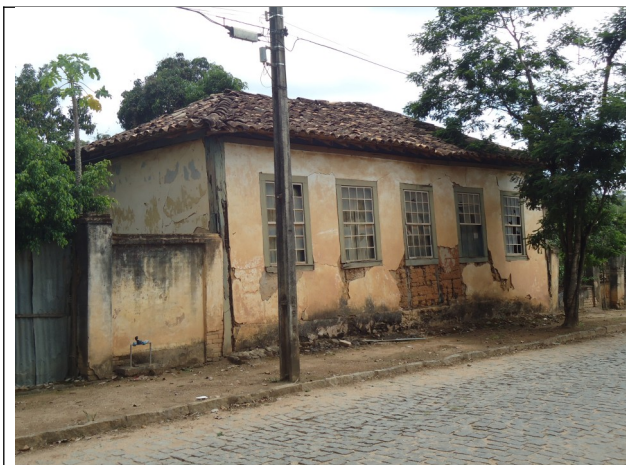
Figura 05 – Fachada frontal da edificação.
