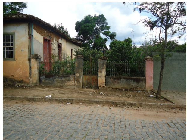
Figura 06 – Acesso principal do imóvel.
