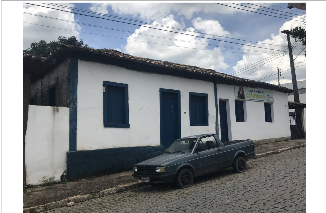
Figura 1 – Fachada frontal do imóvel, em bom estado de conservação. Observa-se que não foi realizada a manutenção do reboco e da pintura na fachada lateral. Fonte: Acervo CPPC.
