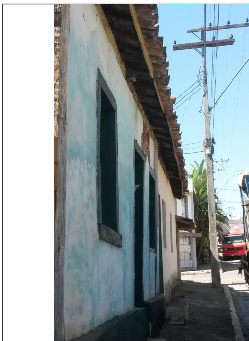
Figura 07 – Registro fotográfico da edificação em análise.
