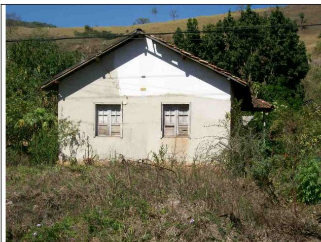
Figura 20 – Casa do funcionário.
