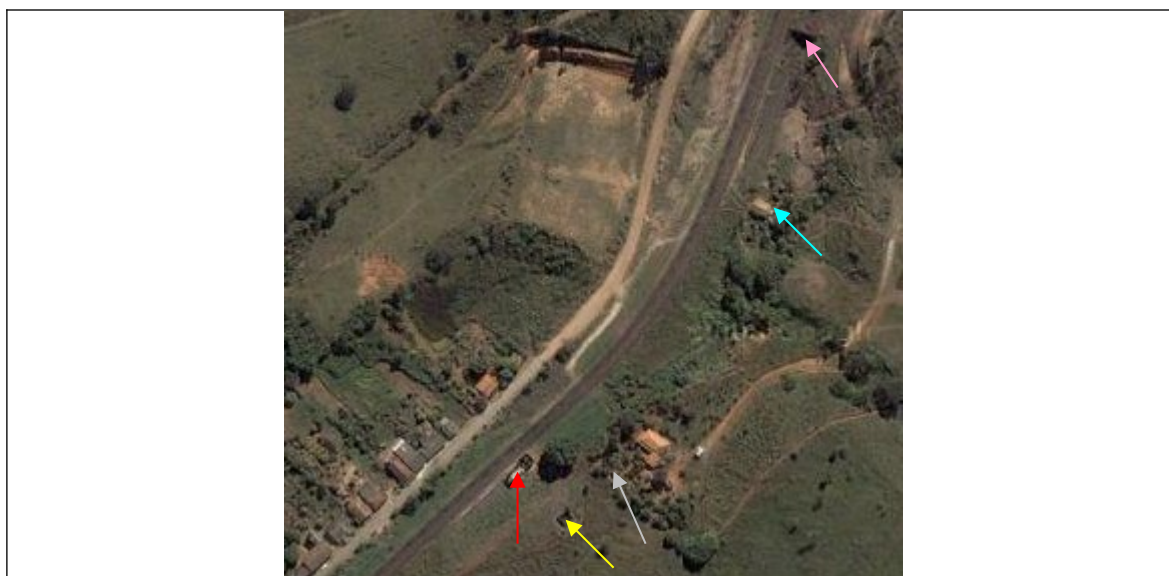
Figura 08 – Vista aérea do conjunto: Estação Ferroviária (seta vermelha), caixa d'água (seta amarela), curral (seta cinza), casa do funcionário (seta azul), túnel (seta rosa).
