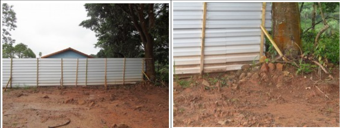
Figuras 9 e 10- Pedras possivelmente remanescentes do segmento de muro suprimido nos fundos da Igreja de São Vicente de Paulo em Ponte das Almorreimas. Fotos da vistoria.
