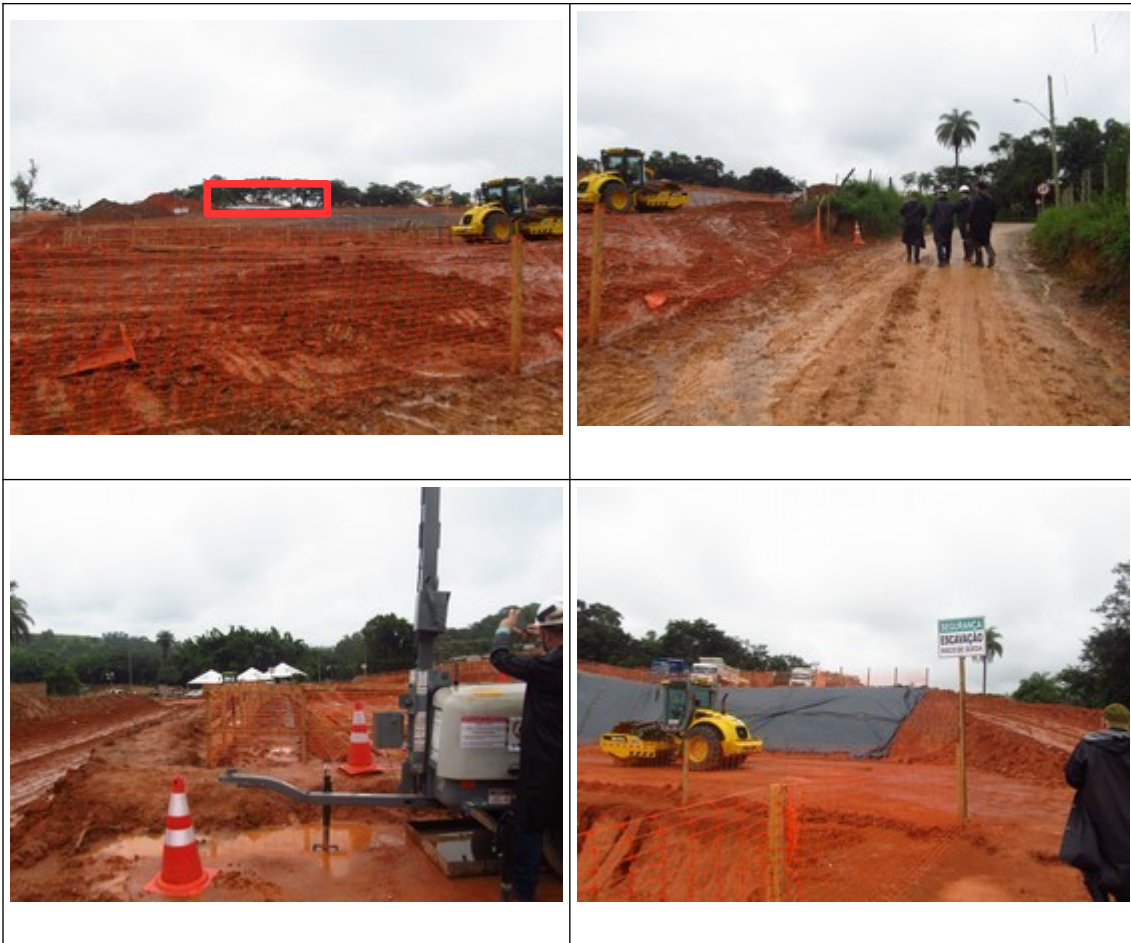
Figuras 13, 14, 15 e 16- Imagens da parte mais baixa do canteiro de obras. Assinalada, na 1ª imagem, a fachada da lateral direita da Igreja de São Vicente de Paulo em Ponte das Almorreimas. Fotos da vistoria.
