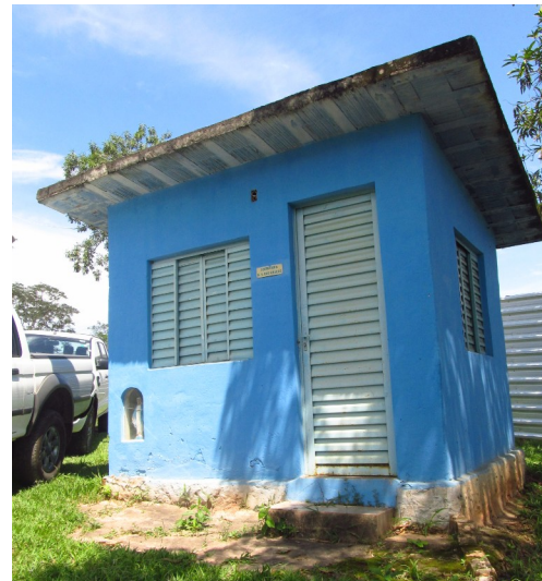
Figuras 23, 24 e 25- Edificações existentes no entorno da Igreja de São Vicente de Paulo. Fotos da vistoria.
