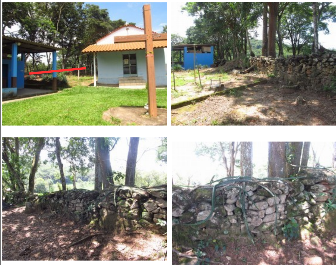
Figuras 26, 27 e 28- Segmentos de muros de pedras no entorno da Igreja de São Vicente de Paulo. Fotos da vistoria.
