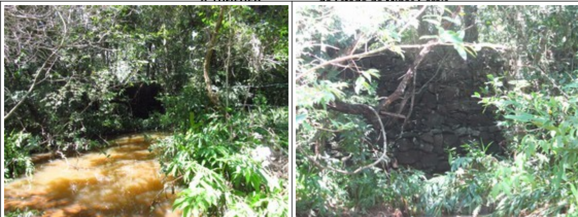
Figuras 38, 39, 40 e 41- Muros de pedras em Ponte de Almorreimas. Nas duas últimas imagens uma estrutura em alvenaria de pedras nas proximidades de uma cachoeira existente em uma propriedade particular. Fotos da vistoria.
