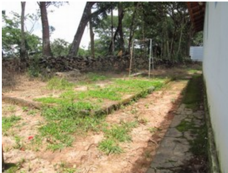
Figuras 29, 30 e 31- Segmentos de muros de pedras no entorno da Igreja de São Vicente de Paulo. Ao fundo das imagens, podem ser identificados os tapumes metálicos Fotos da vistoria.
