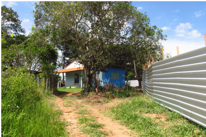
Figuras 20, 21 e 22- Tapumes metálicos implantados no acesso para a Igreja de São Vicente de Paulo. Fotos da vistoria.
