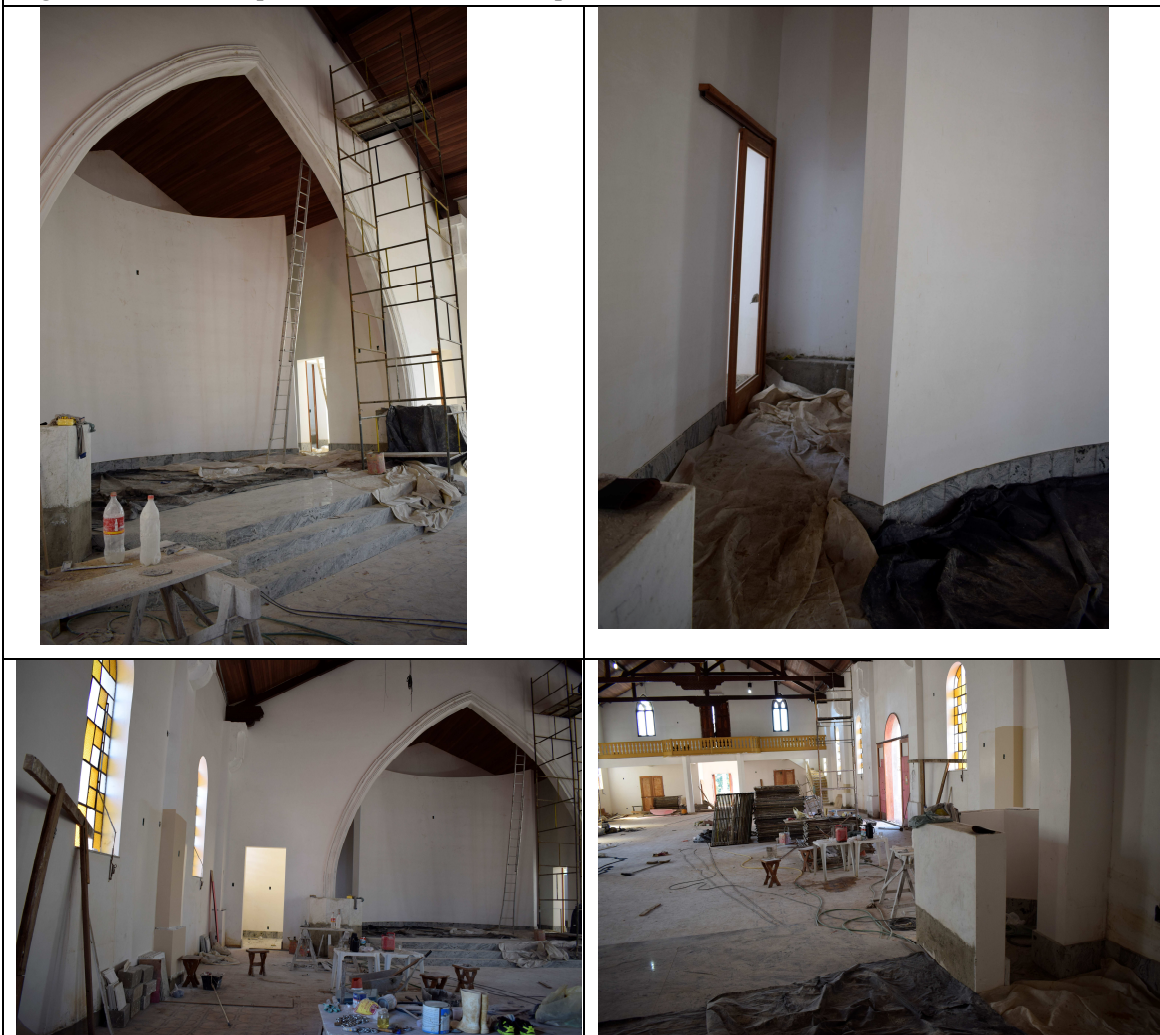
Figuras 07 a 10 – Imagens internas atuais da edificação.
