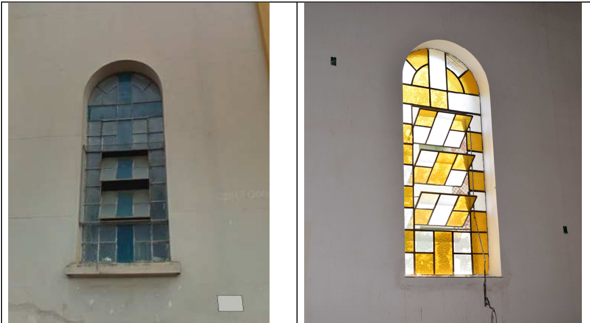
Figuras 05 e 06 – Esquadrias laterais, antes e depois.
